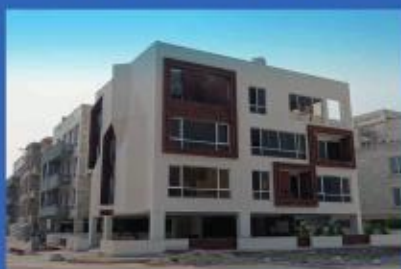
ساختمان مهندس کریمی ۱۱ فاز ۳ نوبنیاد
