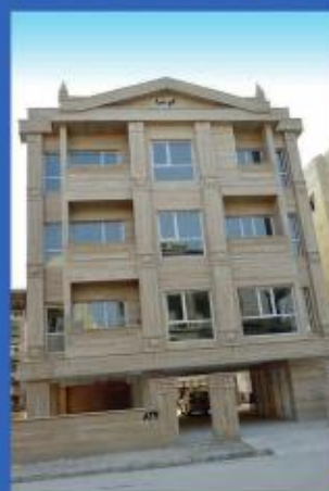
ساختمان کوزه گر فاز ۳ شهرک نوبنیاد
