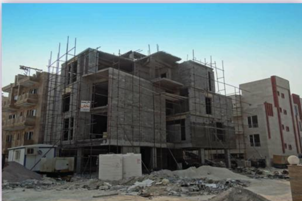
ساختمان مهندس صاحبی (پکیج پروان) فاز ۳ نوبنیاد
