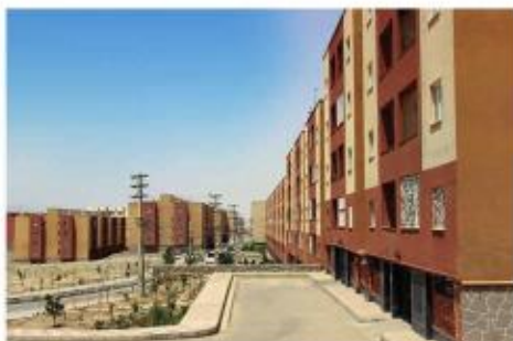
پروژه مسکن مهر شرکت ماراب مهبد کرج
