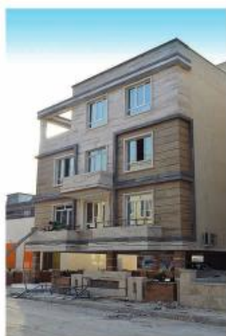
ساختمان مهندس عرفانیان فاز ۳ شهرک نوینیا
