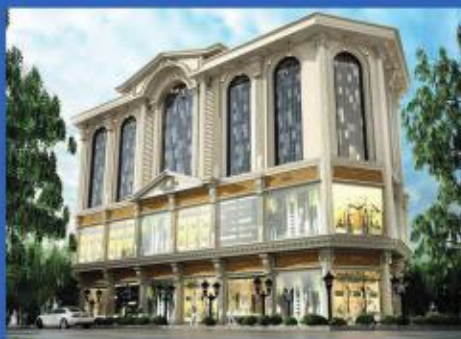
مجتمع تجاری اداری وحید ( در حال ساخت واقع در اندرزگو ) (پکیج براون)
