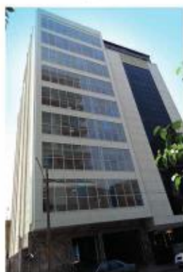
ساختمان مهندس صفری ( خیابان هفتم بخارست )
