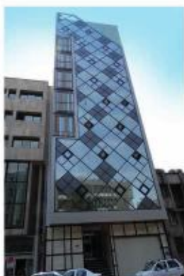
ساختمان مهندس همتی ( بخارست، خیابان ۱۶ )
