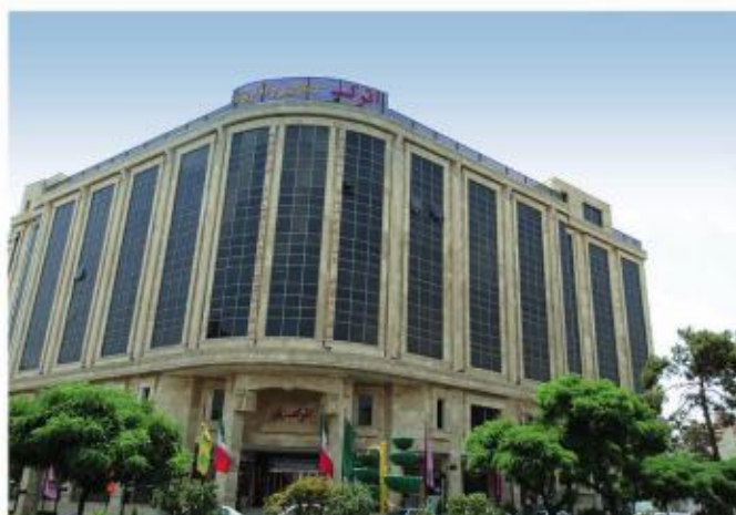
مجتمع اداری تجاری اتورک (بلوار آیت اله کاشانی) (پکیج فوجی)
