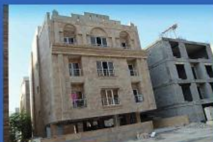
ساختمان مهندس بیدگلی فاز ۲ شهرک نوبنیاد
