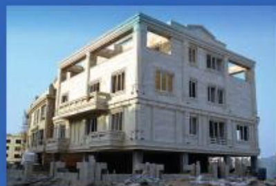
ساختمان مهندسی موسوی فاز ۳ شهرک نوبنیاد
