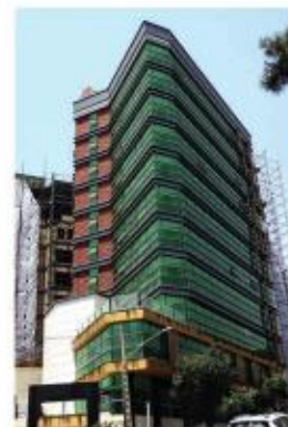
ساختمان مهندس همتی ( خیابان بهاران )
