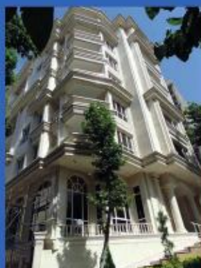
ساختمان مهندس رضایی ( خیابان یاسر ) (پکیج فوجی)
