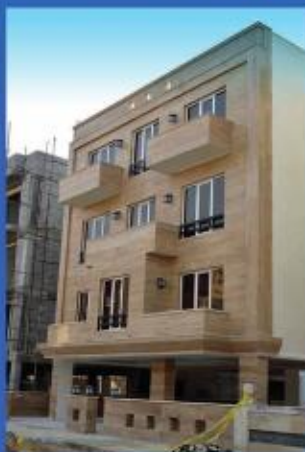
ساختمان مهندسی رثوفی فاز ۳ شهرک نوبنیاد
