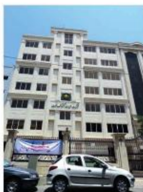
ساختمان شرکت عملیات اکتشاف نفت ( خیابان میرزای شیرازی، کوچه عرفان )
