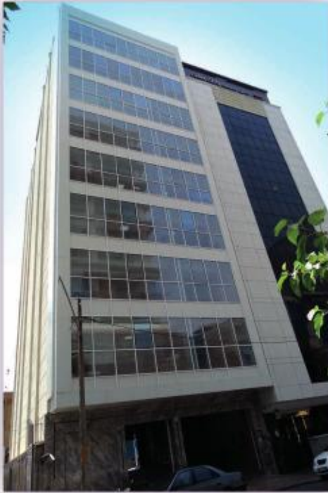
۳۳ - ساختمان صفری ( خیابان هفتم بخارست )
