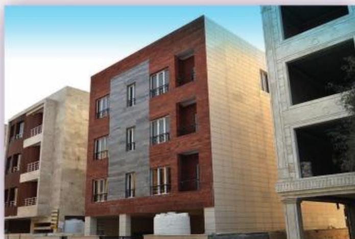
۴۷ - ساختمان موسوی فاز ۳ شهرک نوینیا
